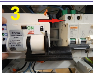
3 Faire coulisser le RDC vers le C60 en intégrant sa mécanique dans celle du C60.
