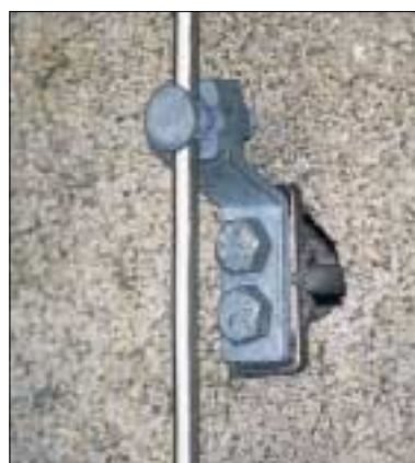
BDT+ RTG : Borne de terre Earth terminal (page 14) Raccord acier galvanisé pour borne de terre Galvanized steel coupling for earth terminal BDT (page 11)
