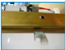
Fixation de la platine sur Rail DIN
